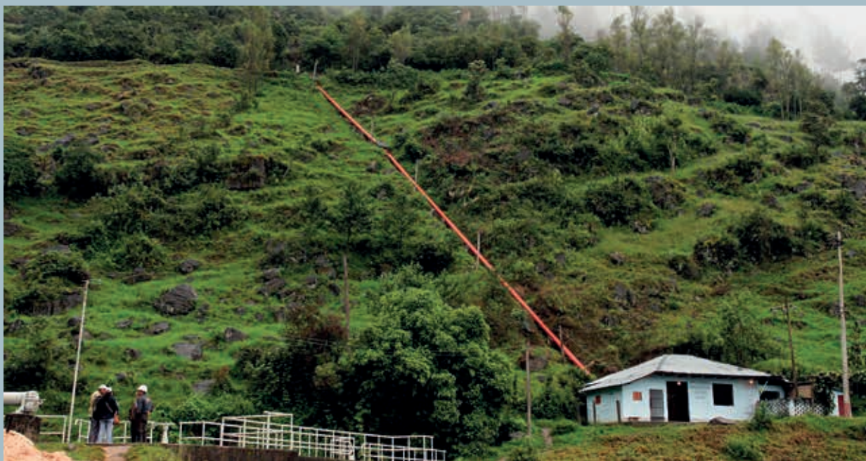
Microcentral en el distrito de Cochán, Cajamarca, Perú, construida en 1995. Logró beneficiar a 150 familias (actualmente más de 300 familias). 📍 Malu Cabellos, Soluciones Prácticas
